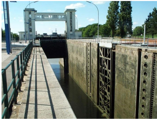
Figure 2 : Sas de l'écluse de Fontinettes avec porte aval levante
